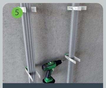
Потолочные профили крепятся к виброизоляционным подвесам саморезами SoundGuard с буром.
