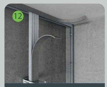
Направляющие профили проклеиваются демпферной лентой SoundGuard ВиброЛента 27. Потолочные профили проклеиваются демпферной лентой SoundGuard ВиброЛента 50.
