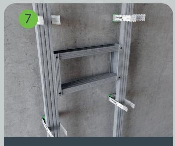
Устанавливаются дополнительные металлические профили в местах установки розеток и выключателей.
