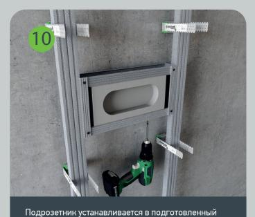
каркас и фиксируется саморезами.
