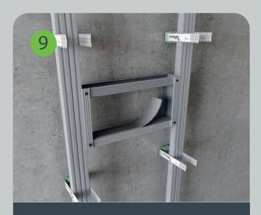
Mecтa установки подрозетника проклеиваются демпферной лентой SoundGuard ВиброЛента.
