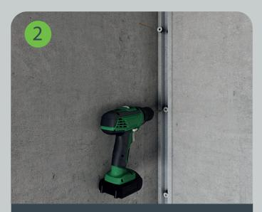
Направляющий профиль крепится через виброкомпенсирующие шайбы SoundGuard ВиброШайба 10х19 с шагом 600 мм с помощью дюбелей SoundGuard DR 6х60 и саморезов SoundGuard УН 4х80\* через просверленные отверстия в профиле.
