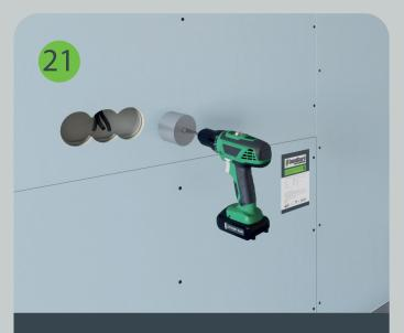
После монтажа звукоизоляционного гипсокартона SoundGuard Gipsofon в нем коронкой просверливается отверстие в месте установки подрозетника.
