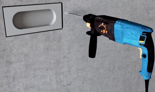
Для вывода розеток в стене выштробить углубление и поместить в него звукоизоляционный подрозетник SoundGuard ИзоБокс Стандарт в один уровень с плоскостью стены.
