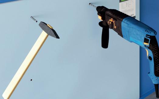
Звукоизоляционный гипсокартон SoundGuard Gipsofon монтируется к стене универсальными саморезами SoundGuard УН 4x80 с дюбелями SoundGuard DR 6x60 с предварительным засверливанием. Расход составляет не менее 22 шт./м<sup>2</sup>.
