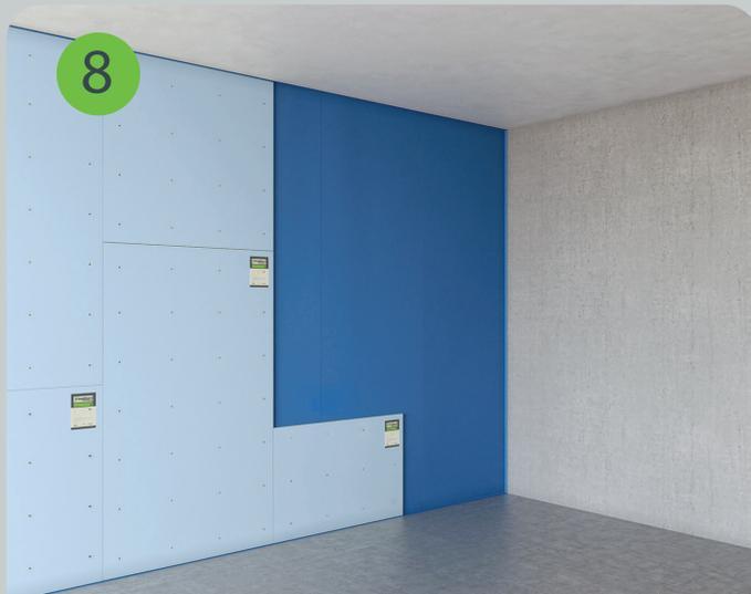
Звукоизоляционный гипсокартон SoundGuard Gipsofon монтируется без зазоров между листами.
