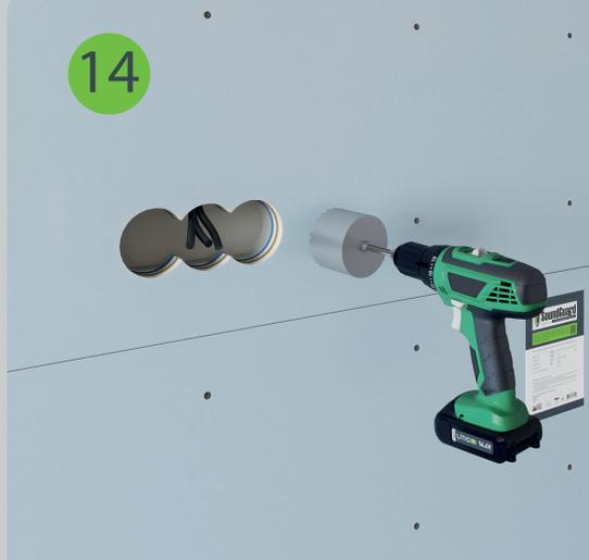
После монтажа звукоизоляционного гипсокартона SoundGuard Gipsobon в нем коронкой просверливается отверстие в месте установки подрозетника.
