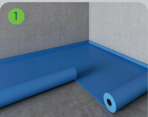
Звукоизоляционный материал SoundGuard ВиброСтоп 25 раскатывается на очищенное от мусора межэтажное перекрытие с нахлестом на стены на толщину стяжки.
