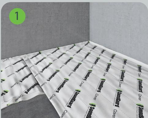
Звукоизоляционный материал SoundGuard Cover раскатывается на очищенное от мусора межэтажное перекрытие с нахлестом друг на друга примерно на 10 – 15 см, а также на стены на толщину стяжки.
