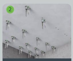
Выполняется монтаж виброизоляционных креплений SoundGuard Vibro PL к перекрытию Анкер-клином SoundGuard вкручиваемым.  $^{*}$
