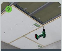
Звукоизоляционные панели SoundGuard Premium устанавливаются вразбежку и крепятся к профилю саморезами SoundGuard ГМ 3,5х32. На одну звукоизоляционную панель требуется не менее 12 саморезов.
