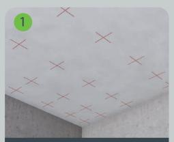
Выполняется разметка потолка для установки виброизоляционных креплений SoundGuard. Шаг подвесов вдоль потолочного профиля SoundGuard Strong ПП 60/27составляет 500 мм, в перпендикулярном направлении – 400 мм.\*
