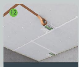
Швы между звукоизоляционными панелями проклеиваются клейкой лентой SoundGuard Tape.
