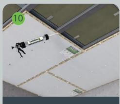
Шляпки саморезов слегка утапливаются и промазываются герметиком SoundGuard Seal.
