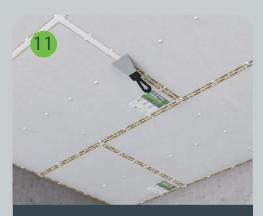
Виброакустичекий герметик SoundGuard Seal наносится на грани панелей в процессе их монтажа, а затем, после установки всех панелей, герметиком промазываются все швы между панелями и места установки саморезов при помощи шпателя.
