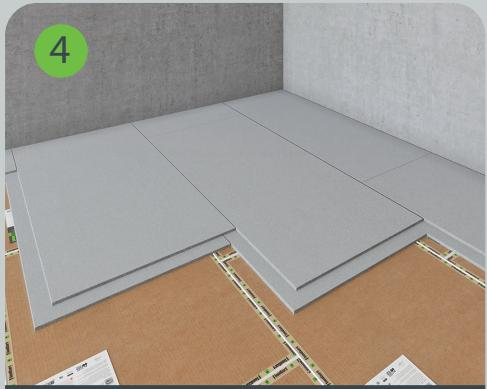
Укладывается плотный материал, такой как KNAUF Суперпол или его аналог. Между покрытием и стенами необходимо оставить зазор величиной 4 мм, который впоследствии заполняется герметиком SoundGuard Seal.
