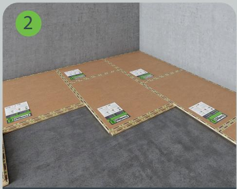
На выровненную и очищенную поверхность пола вразбежку укладываются панели SoundGuard ШумоШит.
